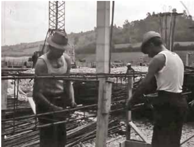
I lavori nel cantiere della nuova scuola Professionale INAPLI sul terreno a San Cassiano.
